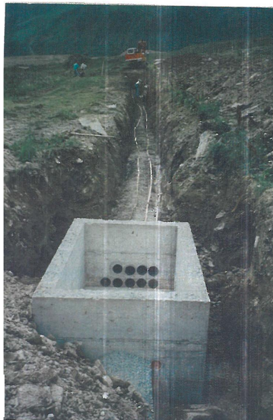
KABELSCHLAUFSCHACHT PZ.SCHPL. WICHLN / ELM
